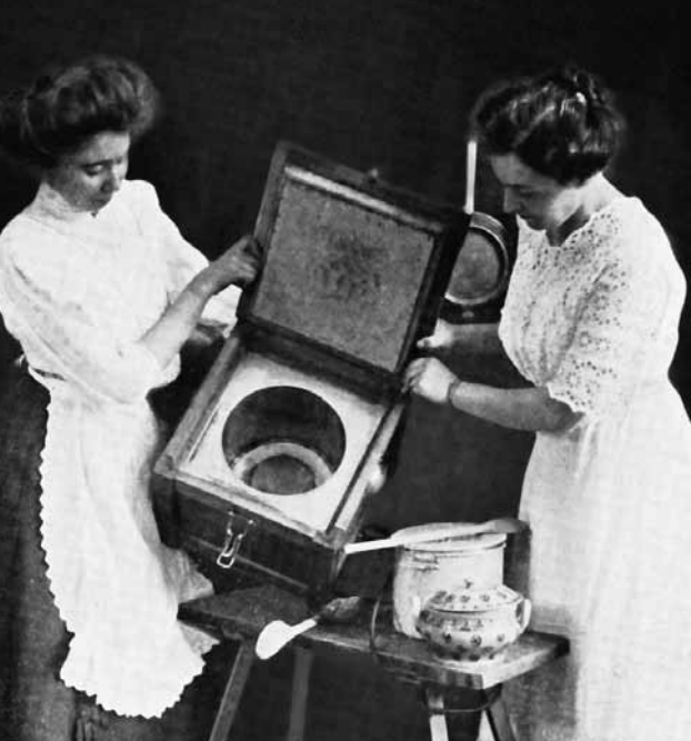
Elektrisch beheizte Kochkiste. Durch die gute Isolation konnte beim Garen viel Energie gespart werden.
