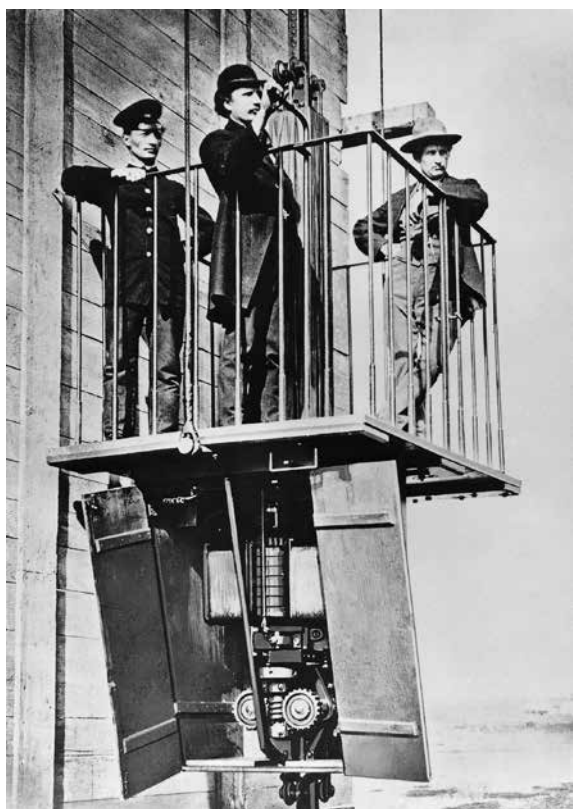
In Mannheim wurde anlässlich der Pfalzausstellung 1880 der erste elektrische Aufzug der Öffentlichkeit präsentiert Siemens Corporate Archives, Berlin
