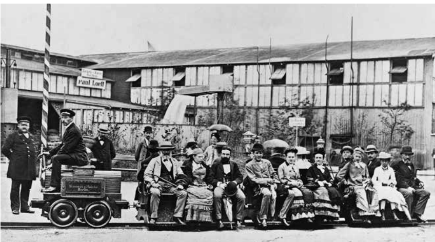
1879 wurde die Dynamomaschine erstmals als Antrieb für eine elektrische Eisenbahn auf der Berliner Gewerbeausstellung eingesetzt / Siemens Corporate Archives, Berlin
